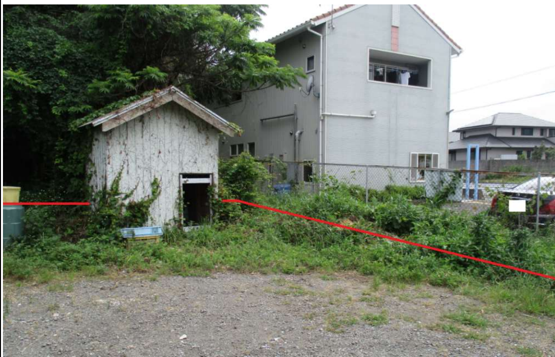
現場北側より撮影
