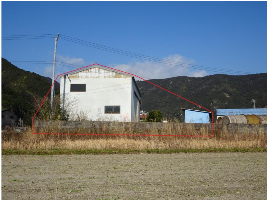
南東側より撮影
