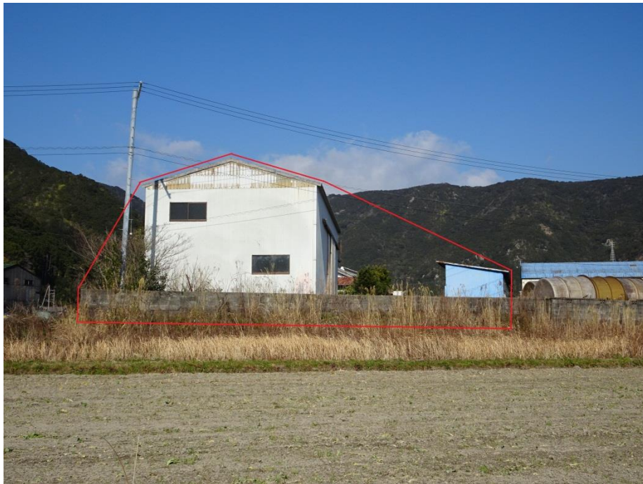
南東側より撮影
